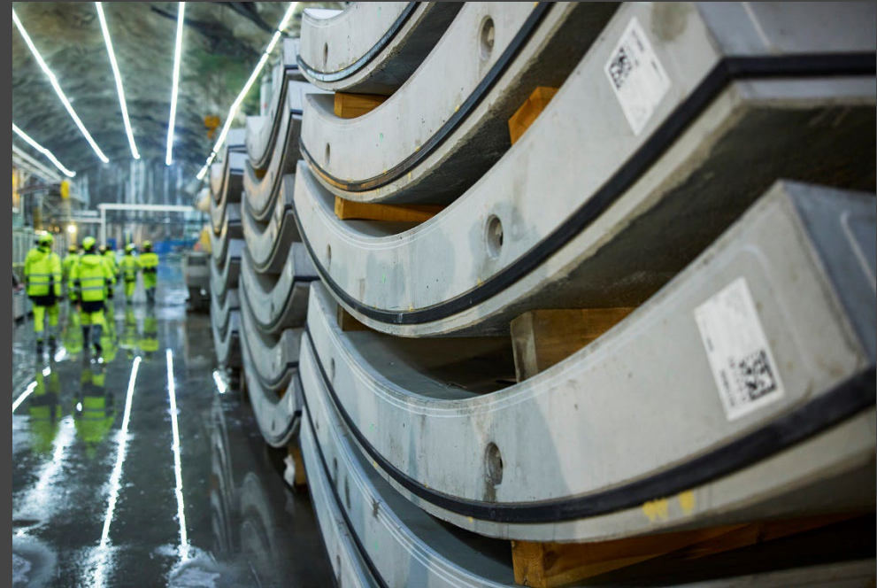
Prosjekt Ny Vannforsyning i Oslo. Foto: Bård Gudim
