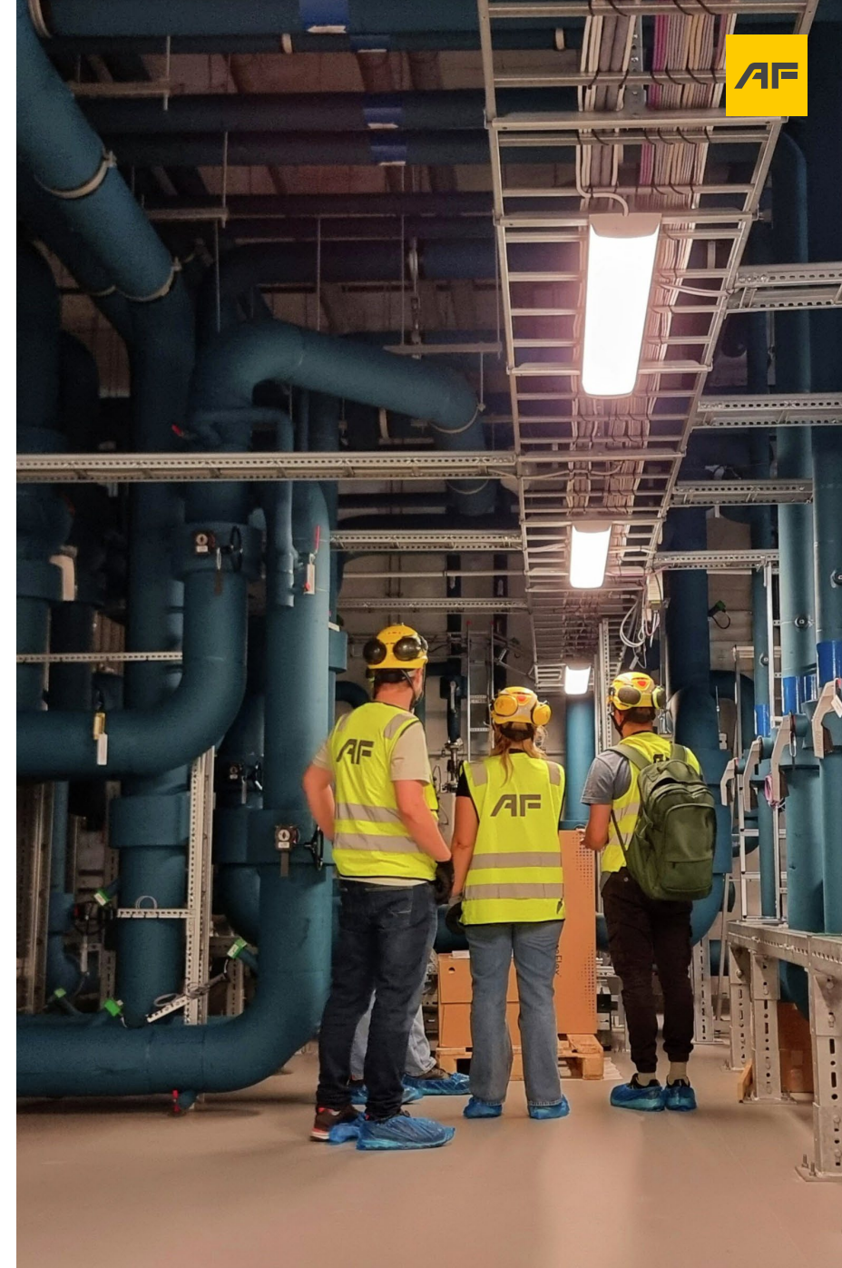
AF Energi leverer energisentral og rørsystemer på nye Drammen sykehus. Foto: AF Gruppen
