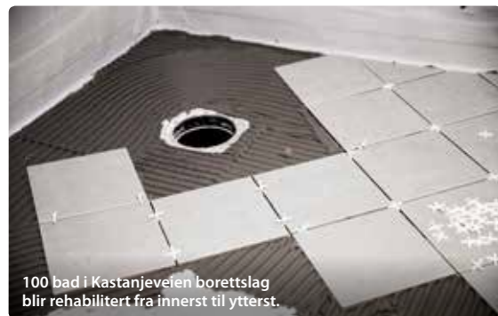
Badene stripes ned og all gammel innredning og overflater fjernes før de bygges opp igjen.
