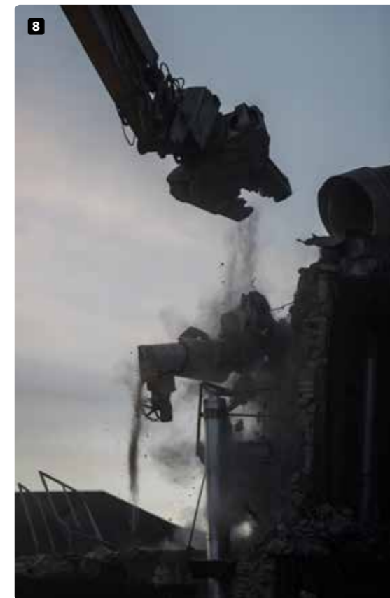
5 Bak den høyeste maskinen ligger et verneverdig bygg som skal bli stående og fylles med kontorer. Det krever nitid nøyaktighet og konsentrasjon å rive alt rundt et bygg med 120 år gammel teglstein som bærekonstruksjon.
