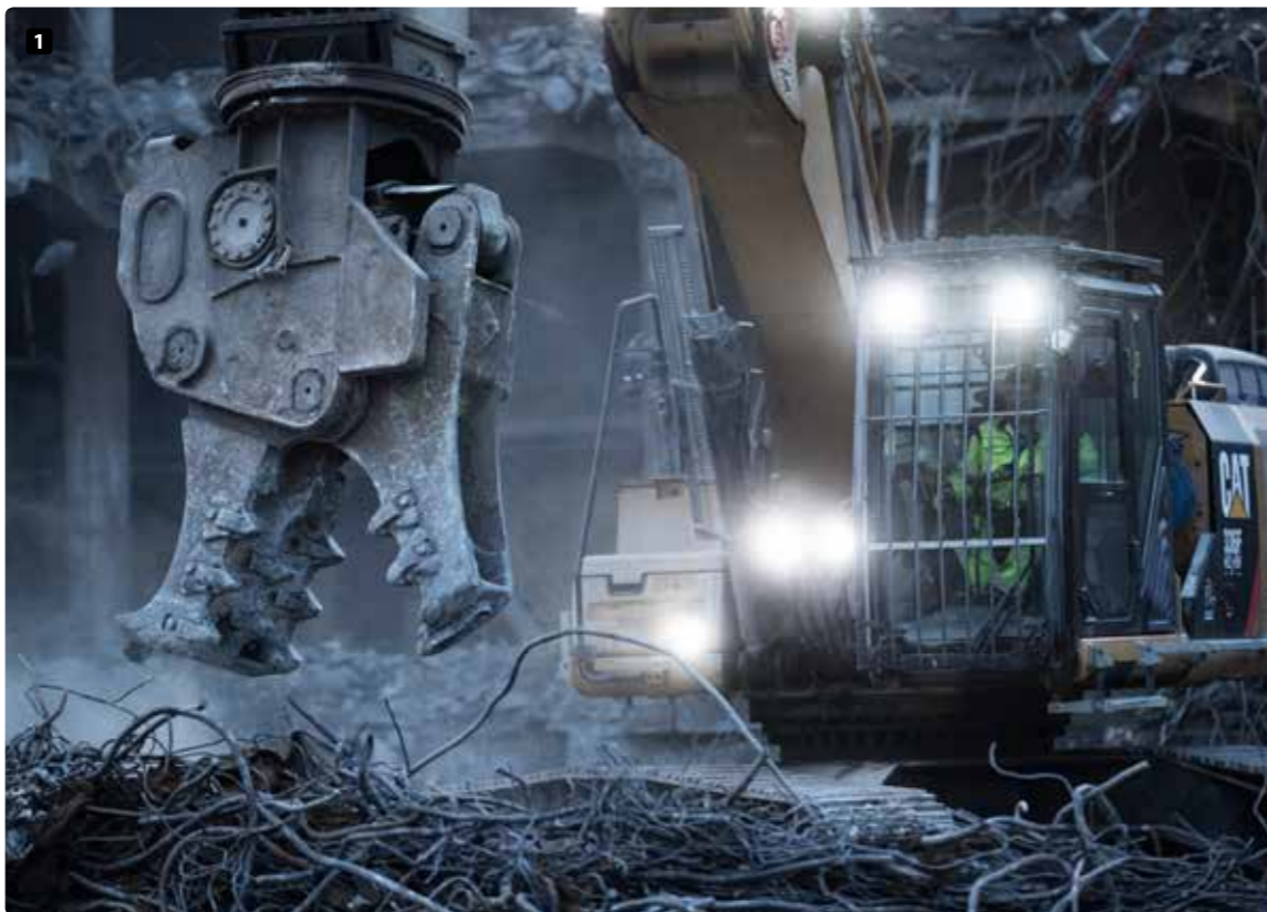
1 Den enorme kjeften på betongknuseren smadrer betongen slik at armeringsjernet blir frigjort. Betongen sendes til deponi, mens stålet blir solgt og gjenvunnet.
