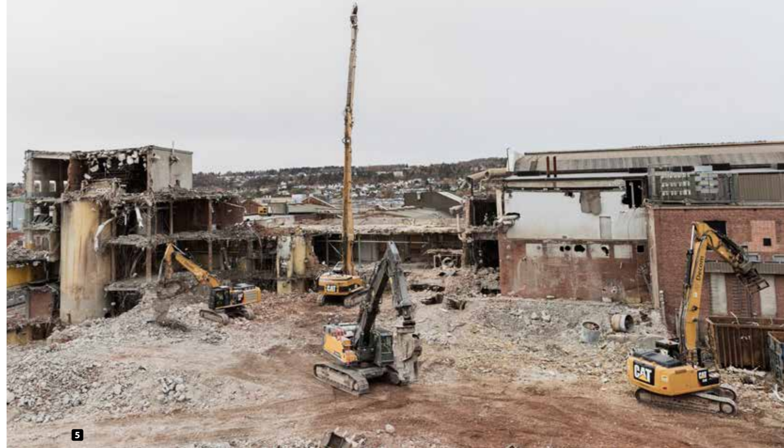
5 Bak den høyeste maskinen ligger et verneverdig bygg som skal bli stående og fylles med kontorer. Det krever nitid nøyaktighet og konsentrasjon å rive alt rundt et bygg med 120 år gammel teglstein som bærekonstruksjon.
