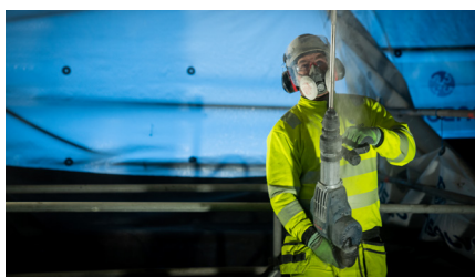
Dormência e formigameiro nas mãos são sinais de risco de danos por vibração.
