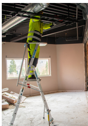
Elevadores e escadas são exemplos de equipamentos que contribuem para reduzir o tempo de exposição a trabalhos acima dos ombros.
