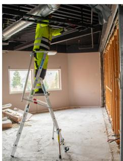
*Подъемники и лестницы с платформой – это примеры оборудования, облегчающего проведение работ выше уровня плеч, которые одновременно позволяют повысить производительность и безопасность труда*
