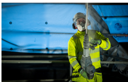
Domningar och stickningar i händerna är tecken på att det finns risk för vibrationsskador.
